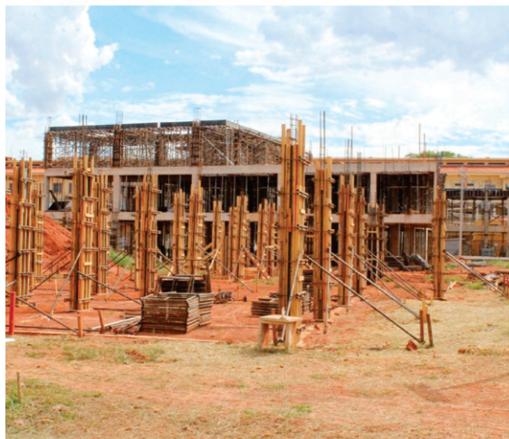
Todas as fundações do novo prédio serão concluídas nas próximas semanas - Foto: Comunicação/FPA.
